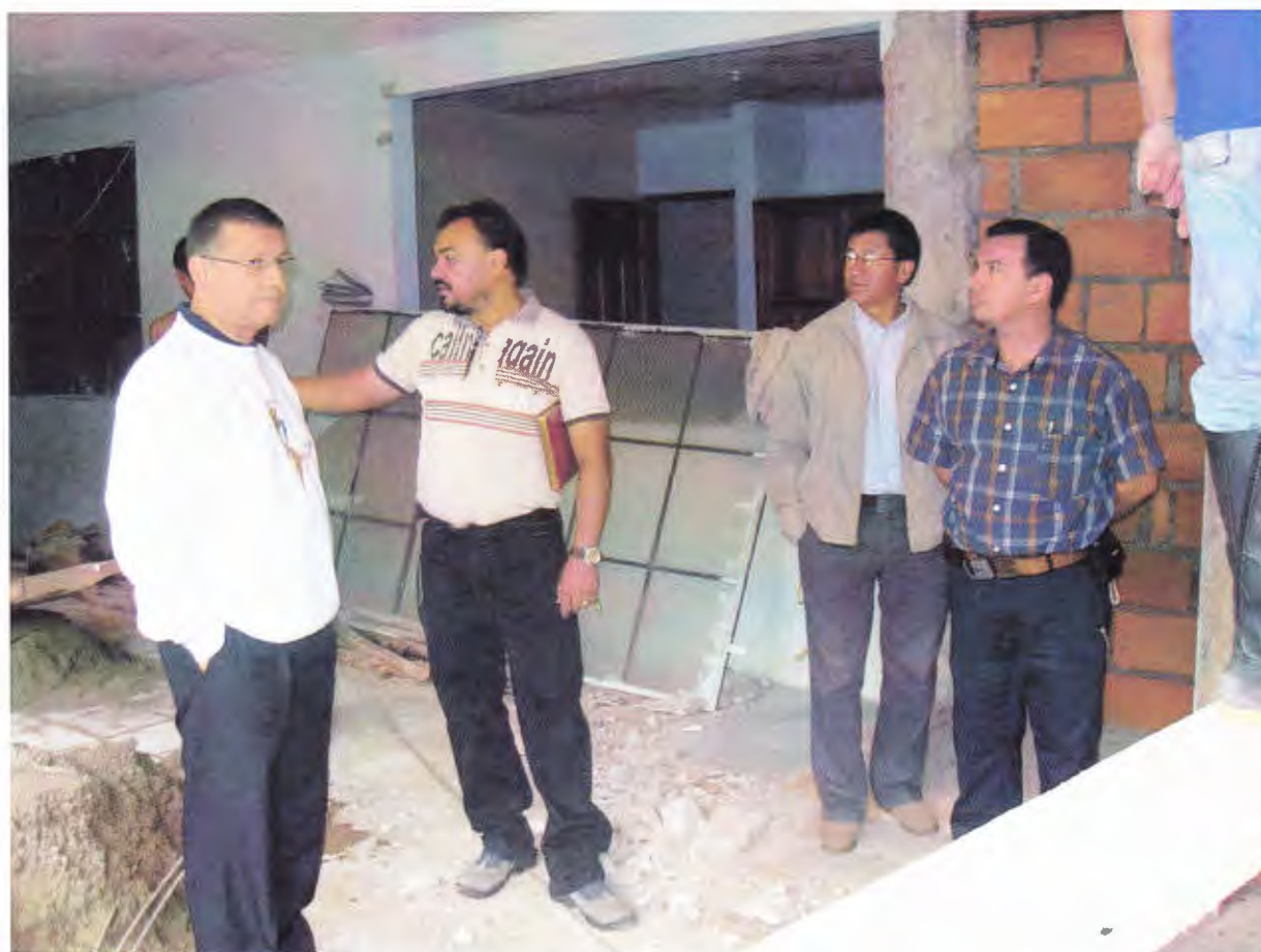
MONS. WALTER HERAS INSPECCIONANDO EL AVANCE DE OBRA EN LA REFORMA QUE SE REALIZA A LA CASA HOGAR DE LA MADRE SOLTERA EN ZAMORA.
